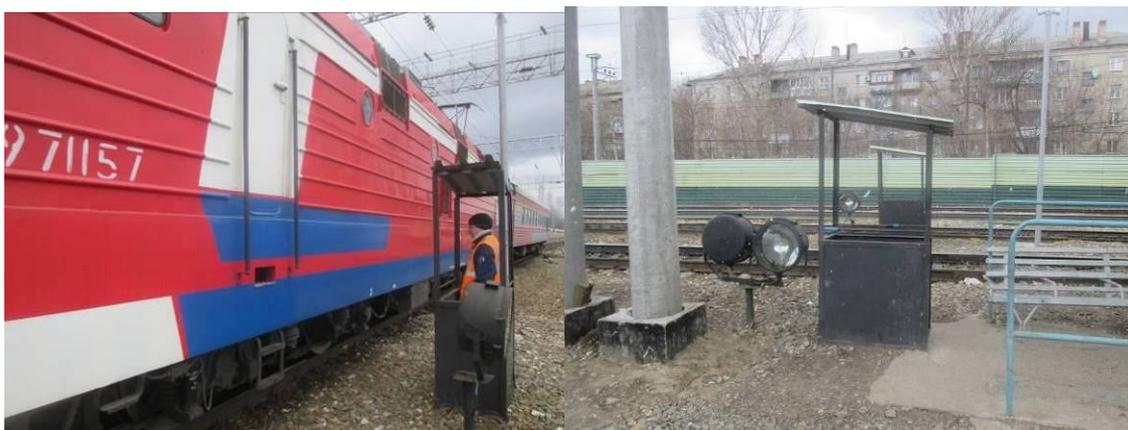
Рисунок 1 – Островок безопасности с прожектором для технического осмотра пассажирских поездов «сходу»
